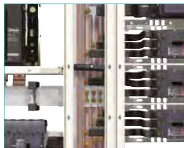
Через комплекты для подсоединения заводского изготовления осуществляется питание аппаратов, установленных справа и слева от силовых шин
